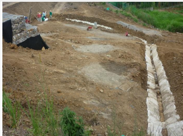
Fotografía 75. Canales de drenaje en sección trapezoidal, contruidos con sacas y suelo cemento (8:1).
