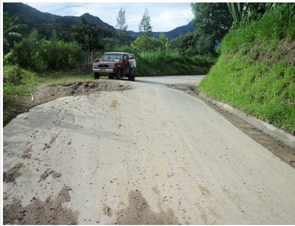
Fotografía 13. Panorámica de la banca en dirección S-N. EVENTO 11. Detalle del bombeo.
