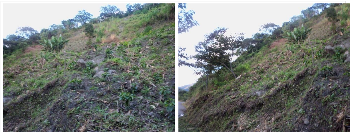
Fotografías 29 y 30. Panorámica en dirección W-E. EVENTO 30. Altura del deslizamiento, medida entre su corona y base del talud de 180.0 m, un ancho de 45.0 m y un espesor de masa deslizada de 1.0 m. El área afectada por el movimiento corresponde a 10.500 m 2 .
