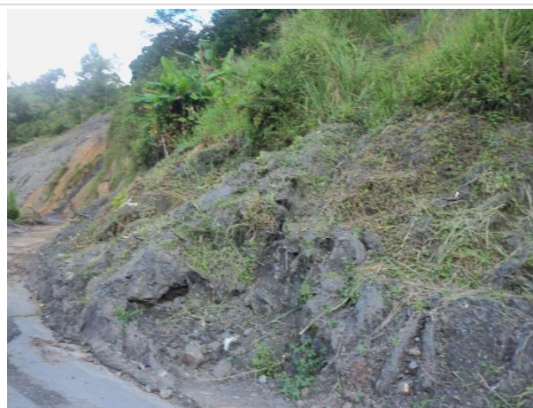
Fotografía 83. Vista en sentido NW-SE. EVENTO 12.
