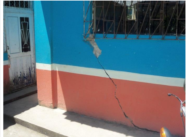
Fotografía 54. Vista exterior de la Institución Educativa Chapiurco en su bloque central. Corresponde a una construcción con muros en ladrillo común y estructura en concreto reforzado
