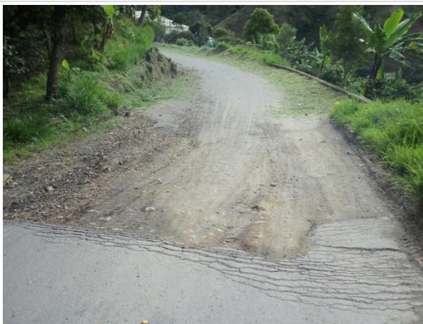
Fotografía 17 y 18. EVENTO 33. Detalles de la afectación de la banca y de la ladera. Se observó la presencia de esquistos grafiticos muy fracturados y de textura foliar.
