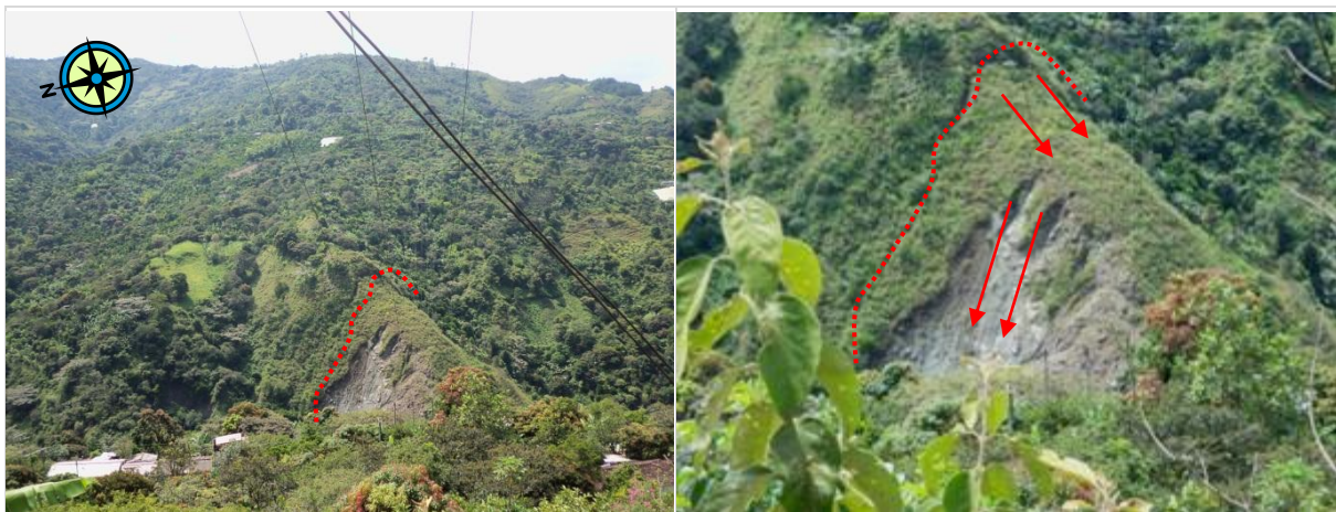
Fotografías 01 y 02. Vista en dirección W-E. EVENTO 01. Panorámicas del deslizamiento. Se indica la fisura arriba de la corona del movimiento, al contorno de la masa deslizada y la dirección del movimiento.
