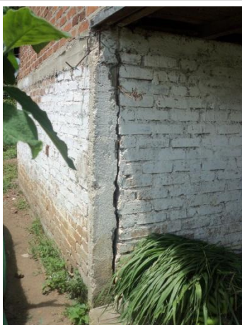
Fotografías 49 y 50. Vivienda Señora. Flor Chávez. Corresponde a una construcción de un piso con muros en ladrillo común, se observó algunas columnas y vigas de corona en concreto reforzado. La vivienda presenta fisuramiento en muros.
