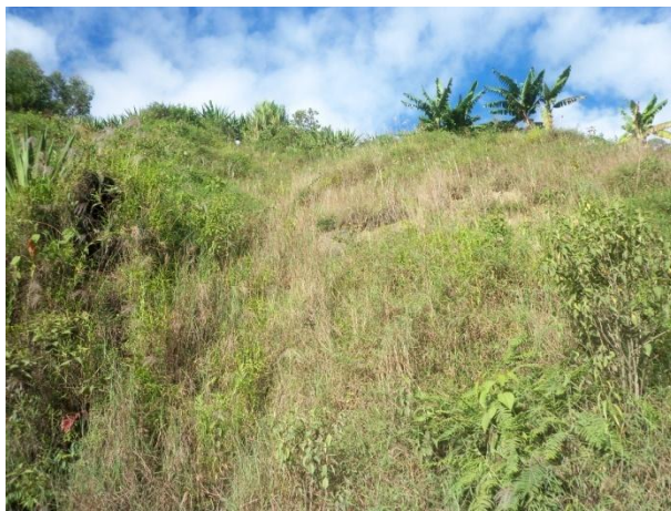
Fotografía 69. Panorámica de la ladera en deslizamiento en dirección W _ E. EVENTO 22. Vereda Campo Bello.
