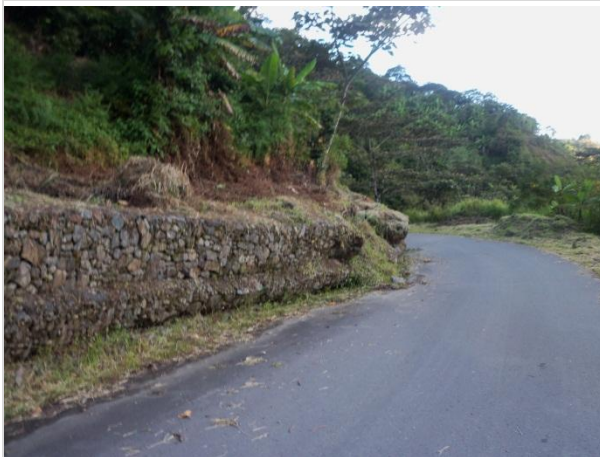
Fotografía 27. Panorámica en dirección SE-NW. EVENTO 31. La altura del deslizamiento es de aproximadamente 4.5 m., se desarrolla en una longitud de 50.0 m.
