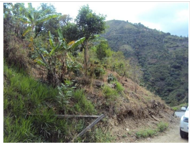
Fotografía 22. Panorámica del deslizamiento. EVENTO 32.
