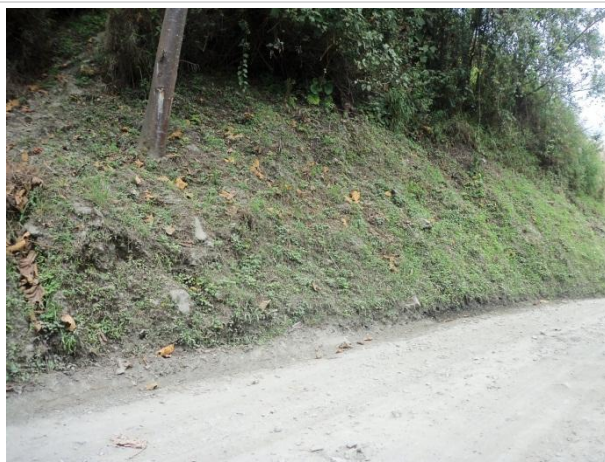
Fotografías 33 y 34. EVENTO 29. La altura del evento es de 80.0 m, tiene un ancho de 51.0m. El volumen deslizado corresponde a 2.180 m 3 y presenta una superficie afectada de 4.350 m 2 .
