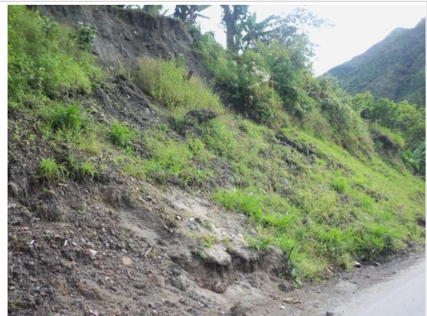
Fotografía 17 y 18. EVENTO 33. Detalles de la afectación de la banca y de la ladera. Se observó la presencia de esquistos grafiticos muy fracturados y de textura foliar.
