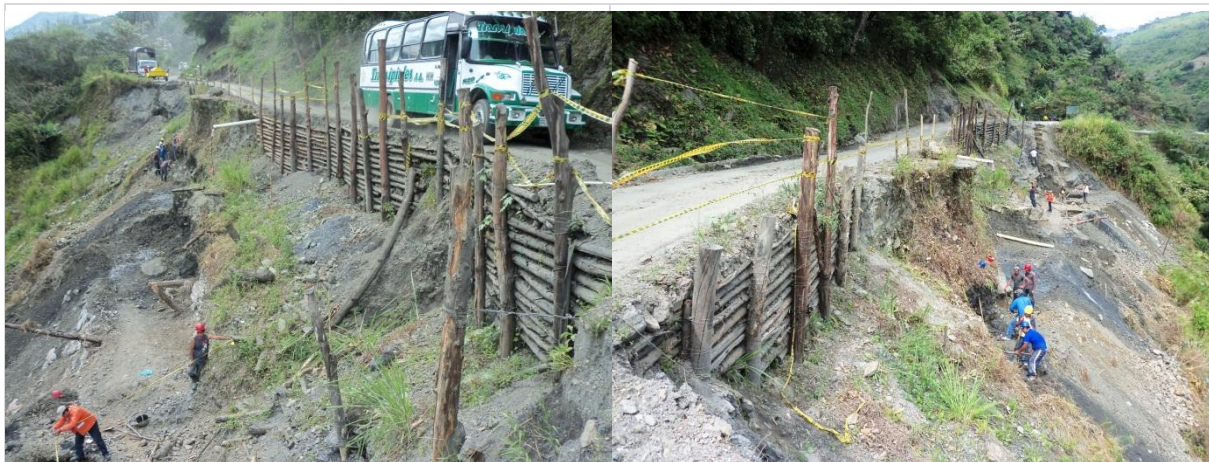
Fotografía 35. Panorámica en dirección S –N. EVENTO 27.
