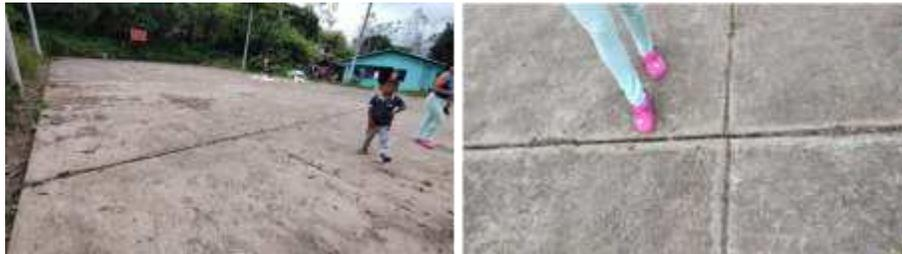
**Figura 85 Hundimiento y separación de baldosas en la cancha para deporte.**
