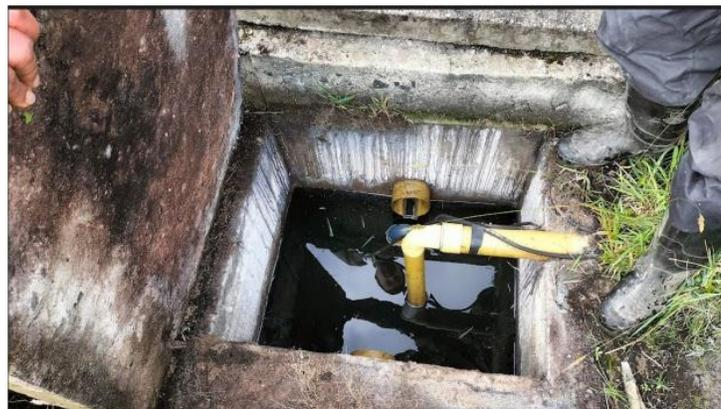
**Fotografía 6.** Cajilla de salida para descarga al alcantarillado por bombeo
