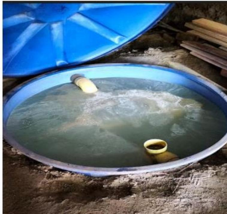
**Fotografía 6.** Tanque séptico 2000 L
