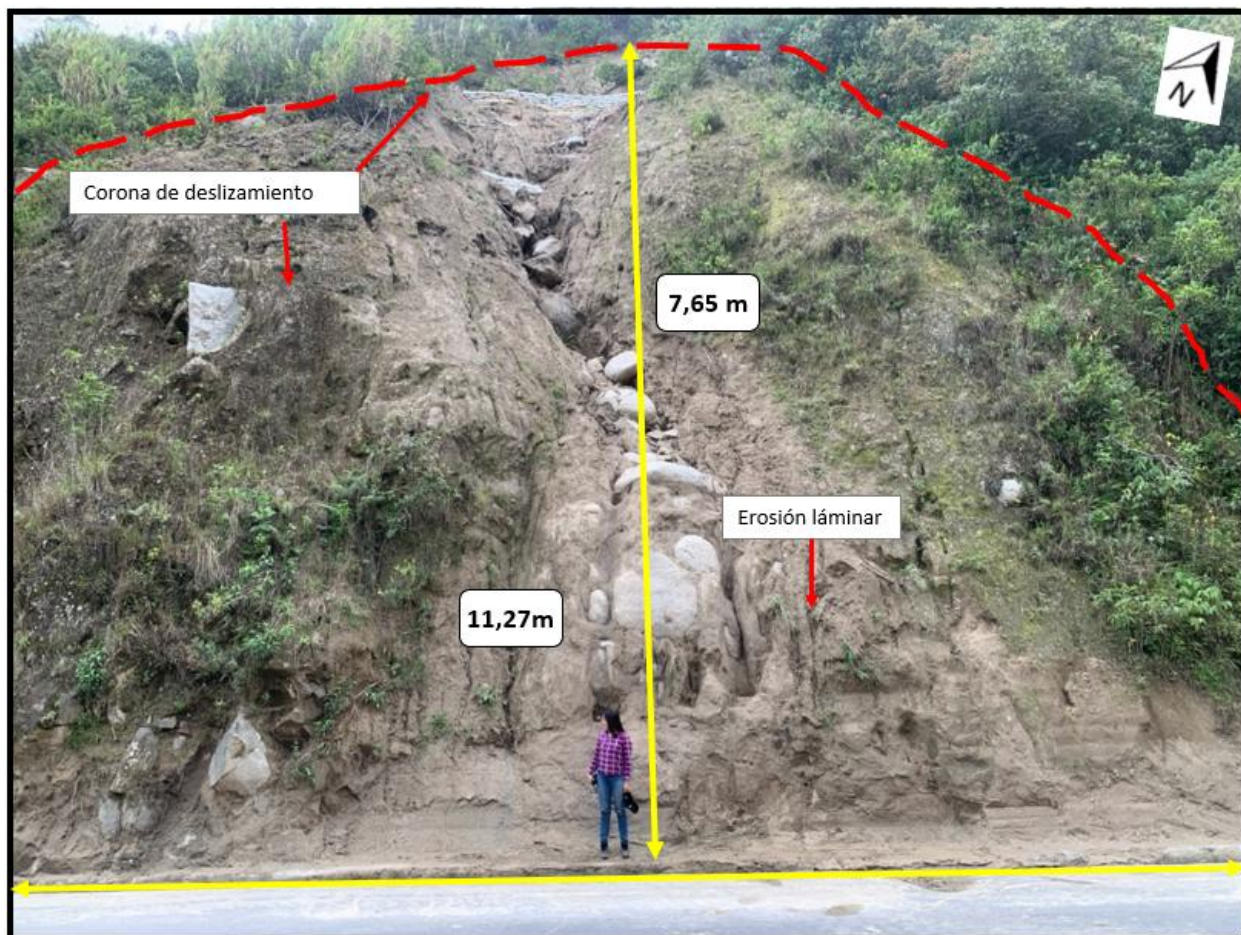
Imagen 5. Deslizamiento traslacional.
