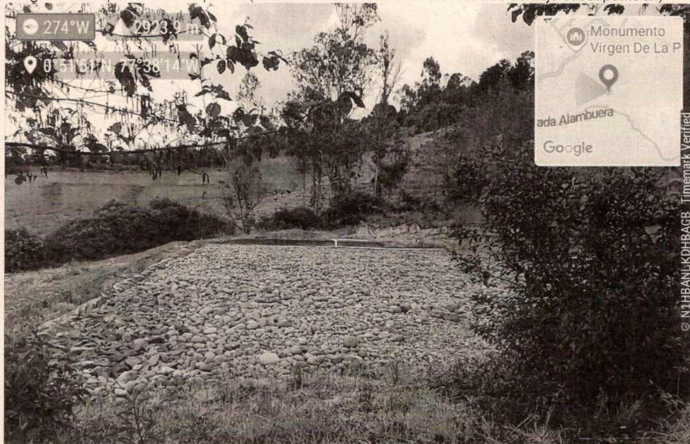
Imagen 7. Tanques llenos de piedra (SEGÚN ESTUDIO diseño Humedales de flujo subsuperficial.)
