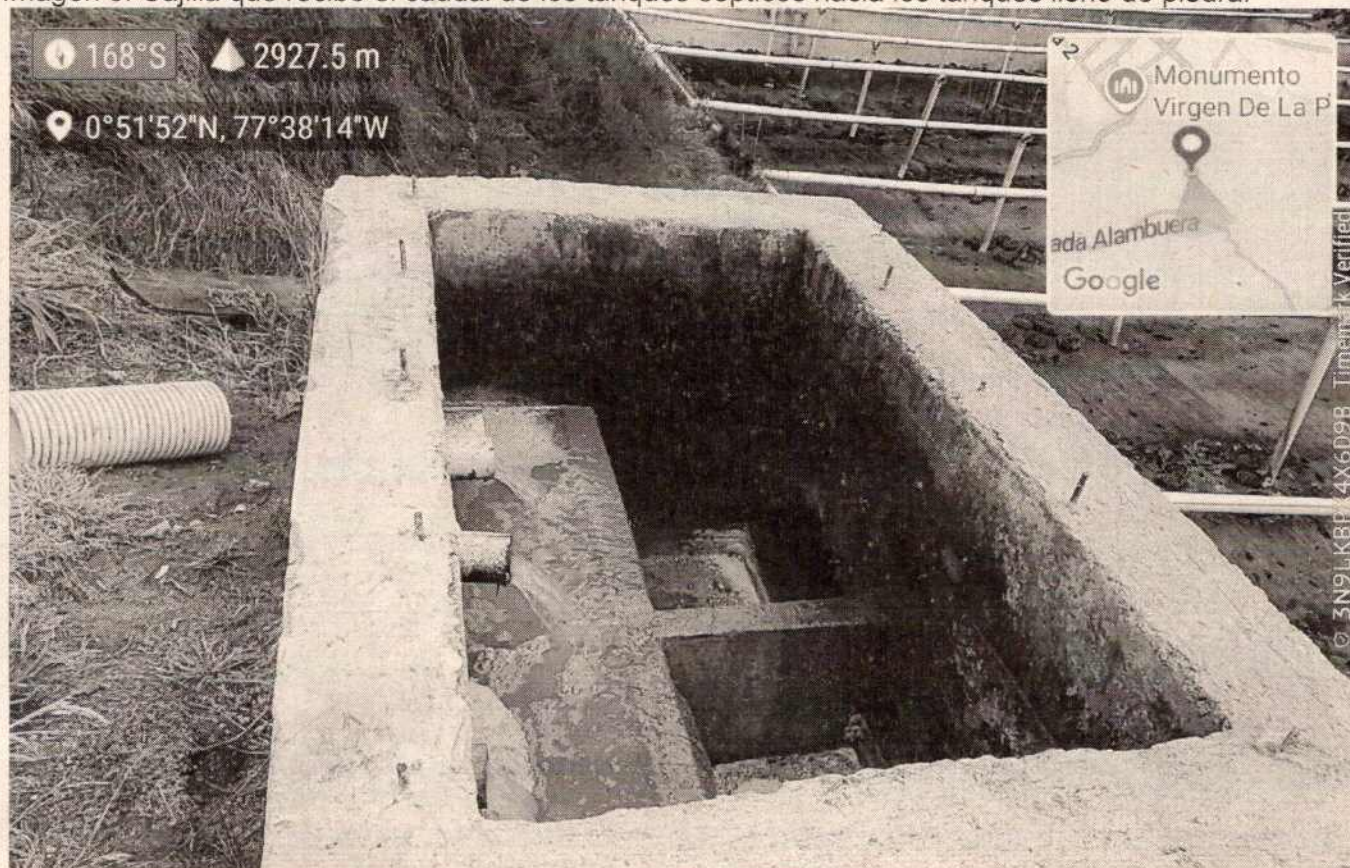
Imagen 8. Cajilla que recibe el caudal de los tanques sépticos hacia los tanques lleno de piedra.
