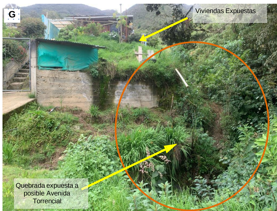
Figura 8. A Corona de deslizamiento- Deslizamiento Traslacional-depósito de material inconsolidado. B. Quebrada expuesta a posible Avenida Torrencial. C. Corona de deslizamiento- Deslizamiento Traslacional. D. Depósito de material inconsolidado. E. Viviendas expuestas. F. Panorámica de deslizamiento. G. Quebrada susceptible a Avenida Torrencial-Viviendas expuestas.
