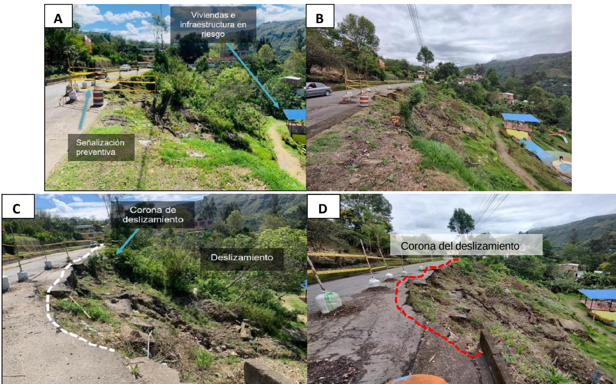
Figura 6. A. Viviendas e infraestructura en riesgo-señalización preventiva. B. Deslizamiento rotacional. C. Corona de deslizamiento. D. Corona de deslizamiento.
