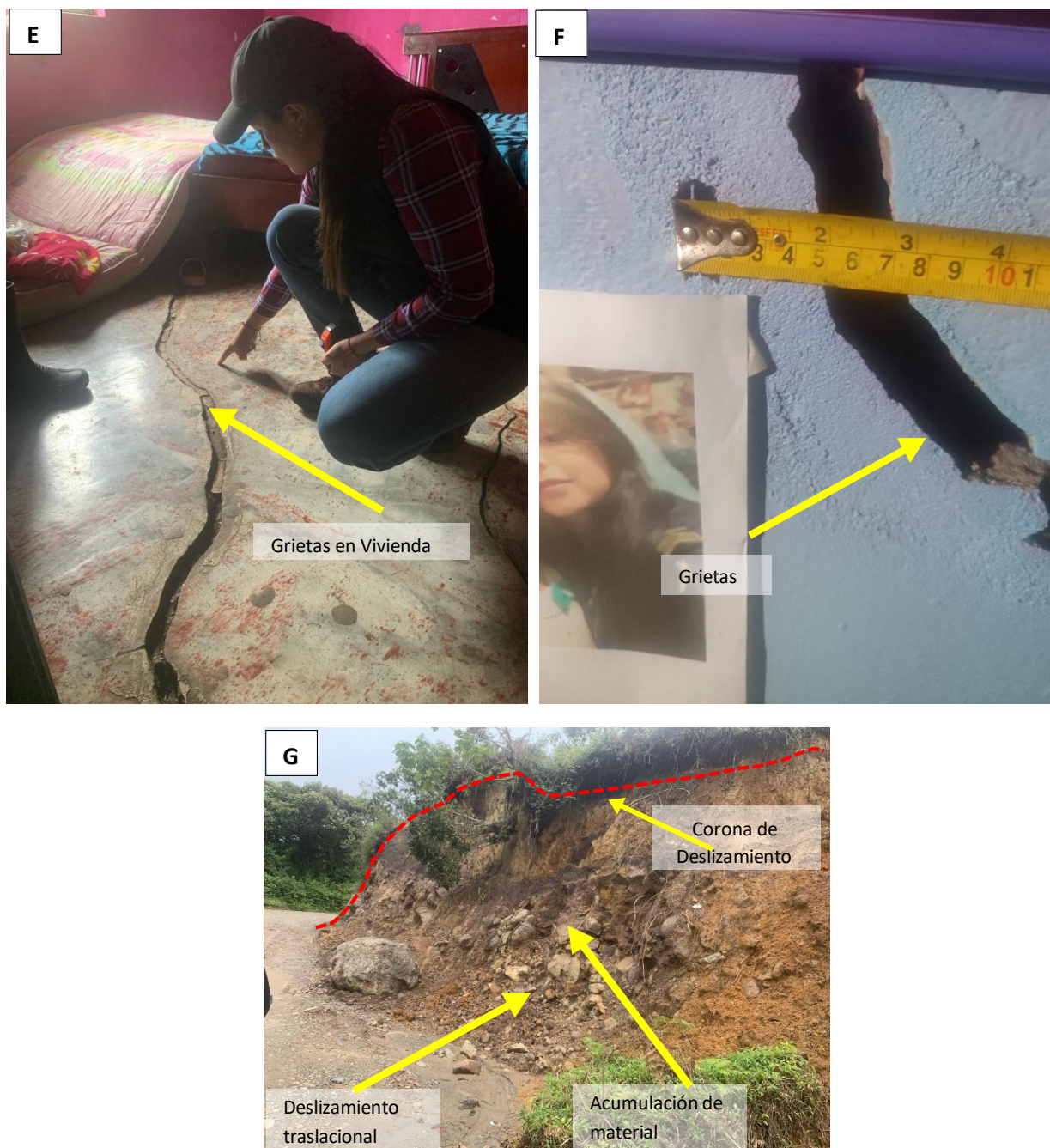
Figura 5. A Grietas. B. Grietas. C. Perdida de banca. D. Quebrada subyacente a Avenida Torrencial. E. Grietas en vivienda. F. Grietas. G. Deslizamiento Traslacional-Corona de deslizamiento-Acumulación de material.
