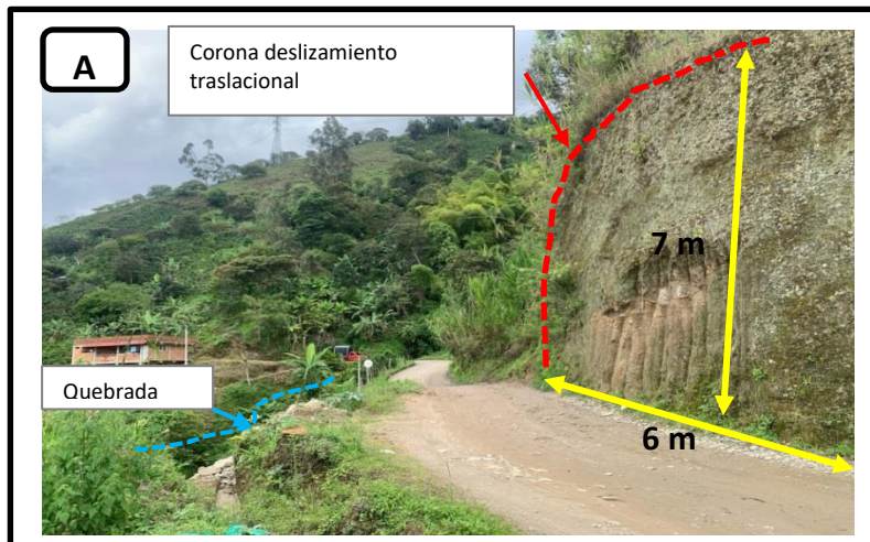
Figura 3. A. Deslizamiento traslacional-Quebrada
