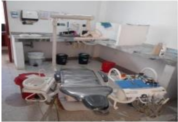
Seguimiento Residuos Peligrosos Hospitalarios, Centro de Salud Santiago de Mallama, Municipio de Mallama
