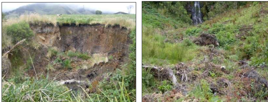
Figura 27. Deslizamiento sobre ribera de la quebrada El Cristal, municipio de Pupiales y avalancha producida por crecida en la quebrada Chorrera Negra, municipio de El Contadero.
