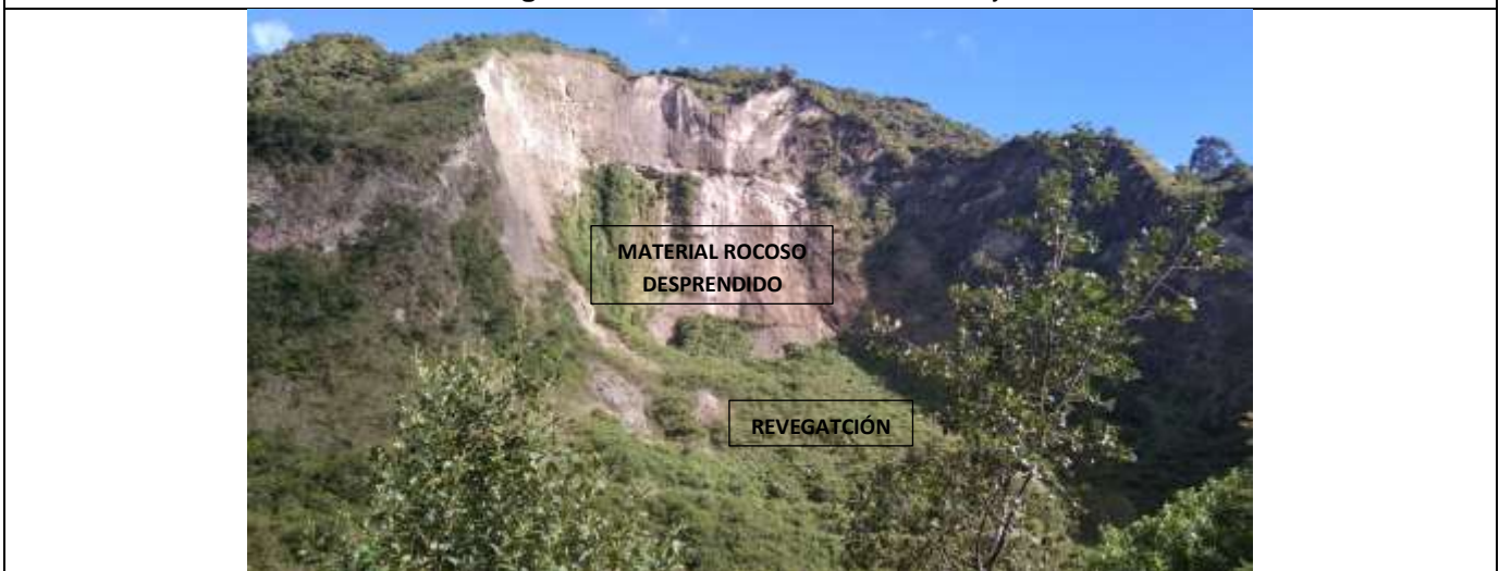
Imagen 9. Bloques de roca depositados en laderas.
