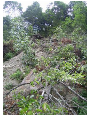
Fotografía 2,3,4. Observe los procesos erosivos desarrollados en el talud inestable (cárcavas, reptación erosión hídrica).
