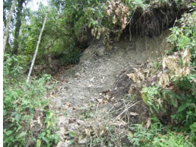
Fotografía 2,3,4. Observe los procesos erosivos desarrollados en el talud inestable (cárcavas, reptación erosión hídrica).
