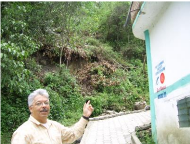
Fotografía 2,3,4. Observe los procesos erosivos desarrollados en el talud inestable (cárcavas, reptación erosión hídrica).
