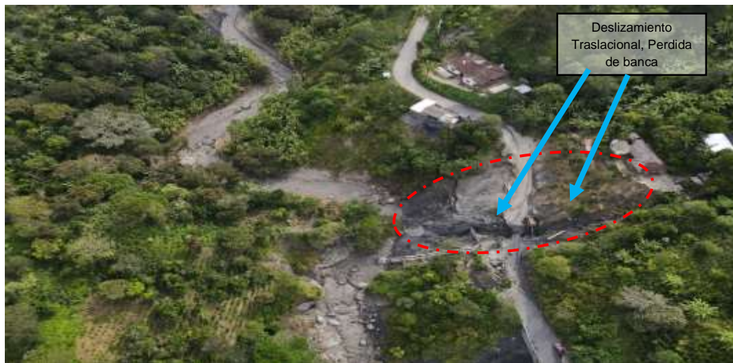
Zonas que presentan Deslizamiento Traslacional, Perdida de banca
