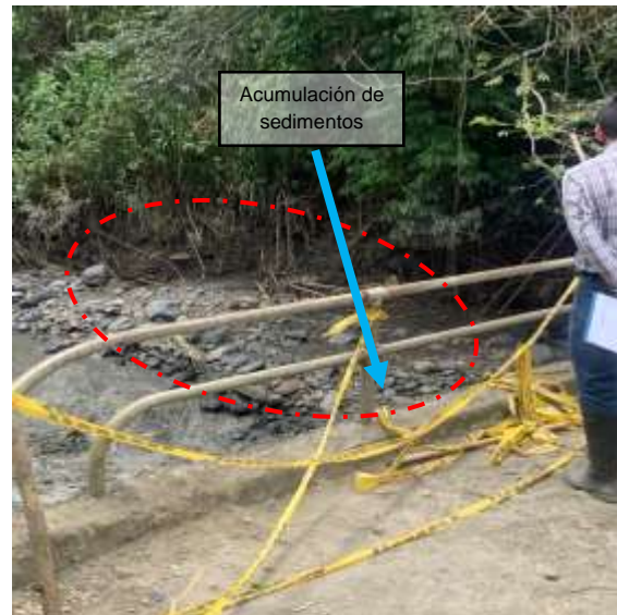
Zona que presenta la Remoción de material del cauce del río para reducir la acción socavación lateral del río Quiña que se encuentra afectando la vía que conduce a la vereda Chapiurco, vereda El Salado.
