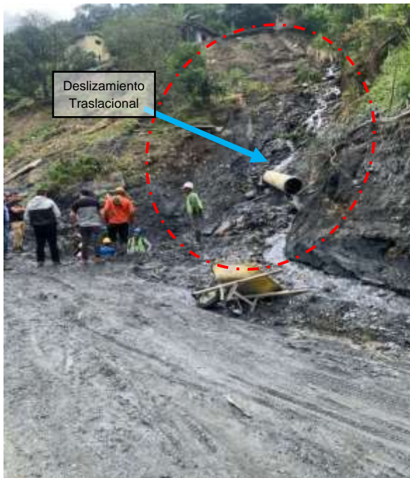
Zona que presenta, Deslizamiento traslacional, Perdida de banca
