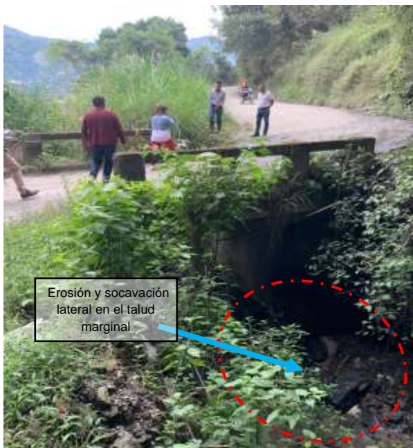
Zona que presenta, Deslizamiento, Erosión y Socavación Lateral
