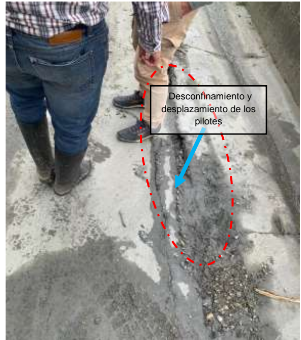
Zona que presenta, Socavación Lateral, desconfinamiento y desplazamiento de los pilotes
