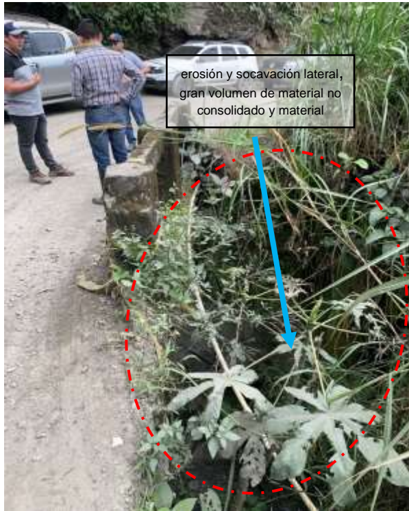
Zona que presenta, Socavación Lateral y Gran volumen de material no consolidado
