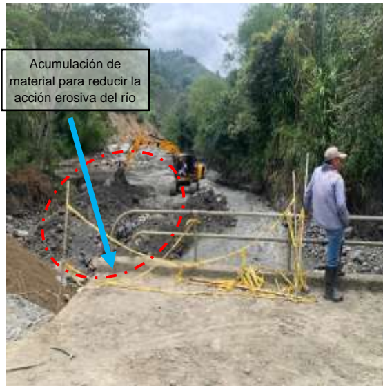
Zona que presenta la Remoción de material del cauce del río para reducir la acción socavación lateral del río Quiña que se encuentra afectando la vía que conduce a la vereda Chapiurco, vereda El Salado.
