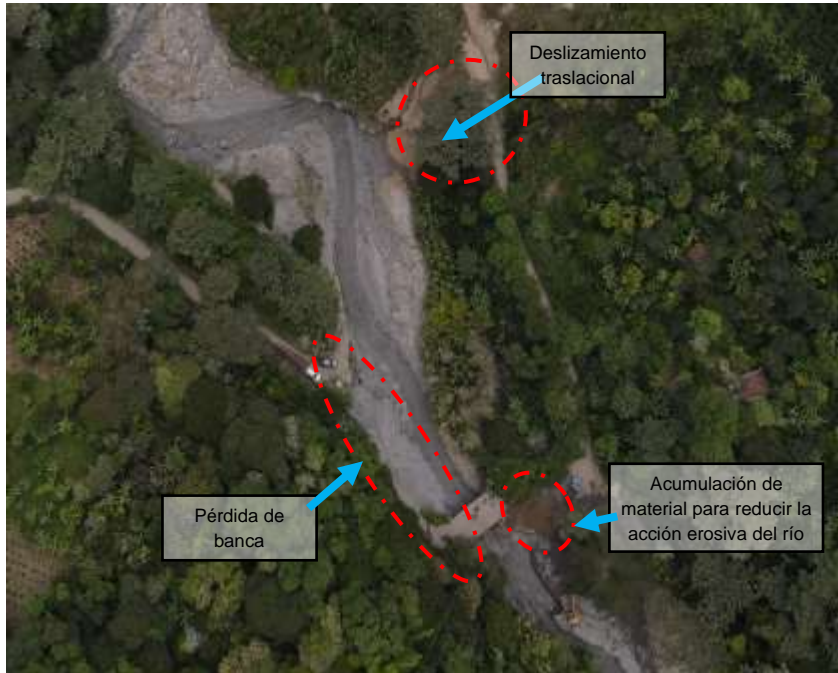
Zona que presenta, Deslizamiento traslacional, Acumulación de sedimentos y Acumulación de material para reducir la acción erosiva del río.
