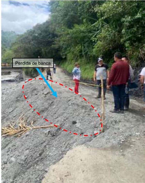
Zona que presenta, Perdida de banca, Acumulación de sedimentos y Deslizamiento traslacional
