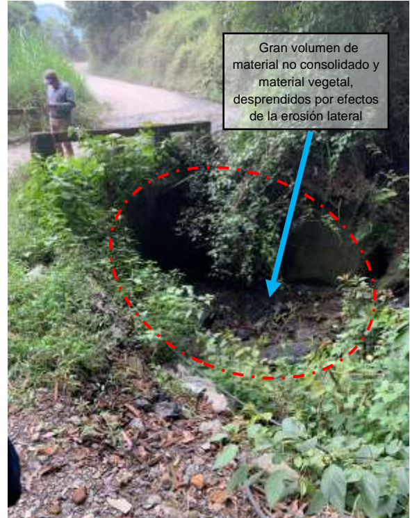
Zona que presenta, Socavación Lateral y Gran volumen de material no consolidado
