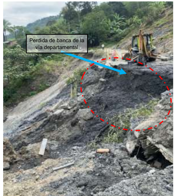
Zona que presenta, Deslizamiento traslacional, Perdida de banca
