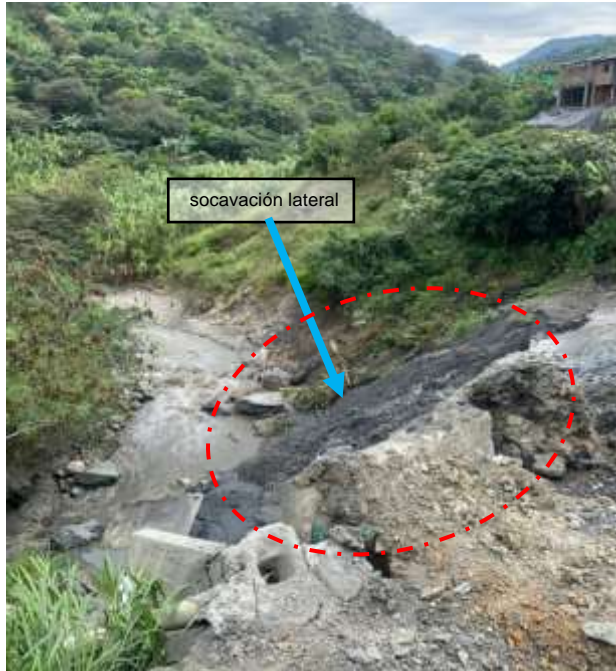
Zona que presenta, Socavación Lateral, desconfinamiento y desplazamiento de los pilotes
