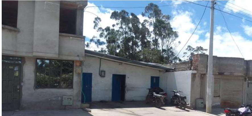
Fotografía 1. Instalaciones Lácteos la Playa
